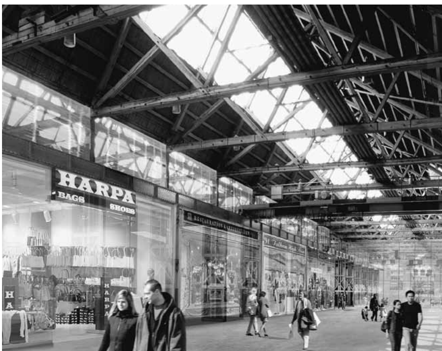
In der Halle 1012 entsteht eine neue öffentliche Passage zwischen Dialogplatz und Zürcherstrasse.
